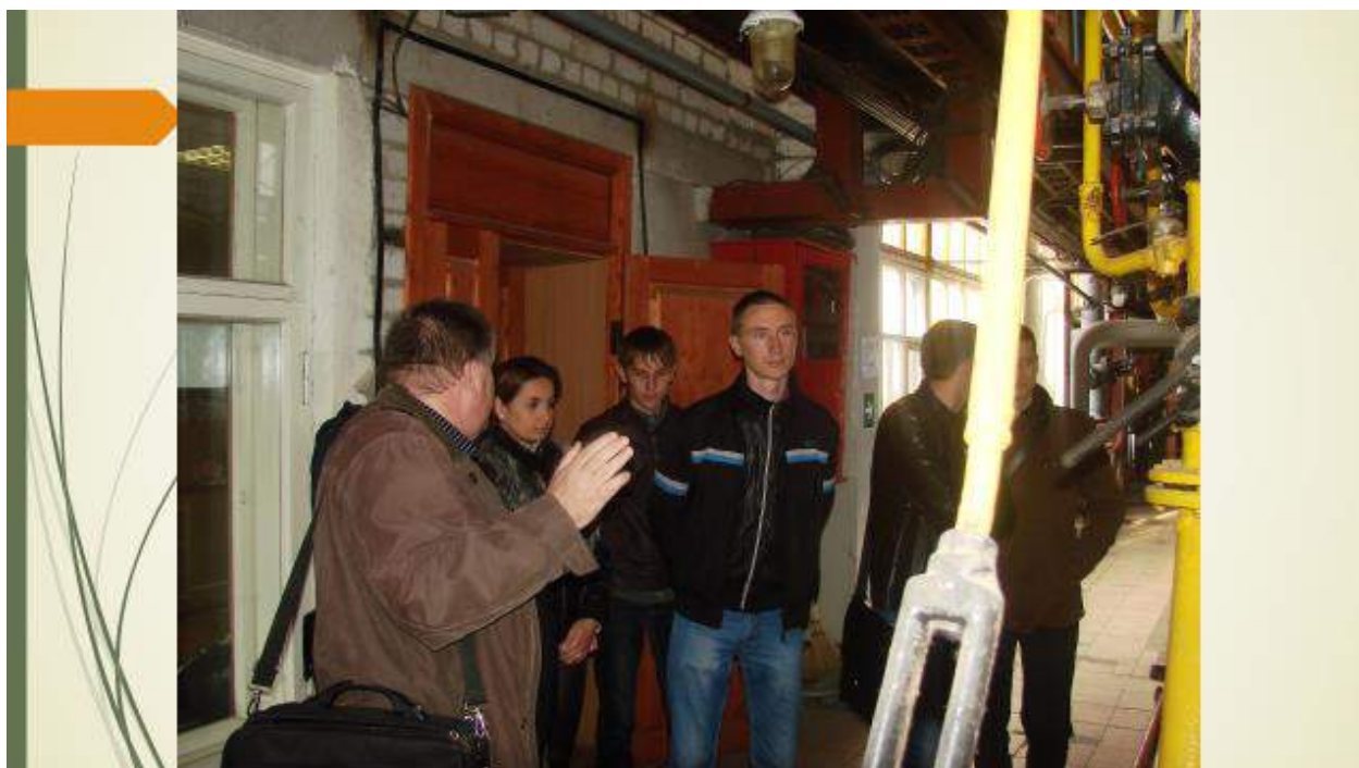
Фото 1. Студенты на экскурсии по новой технике (теплоэнергетическое оборудование котельной).
